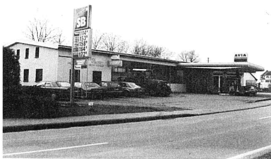
Werkstatt und Tankstelle Essendorf
