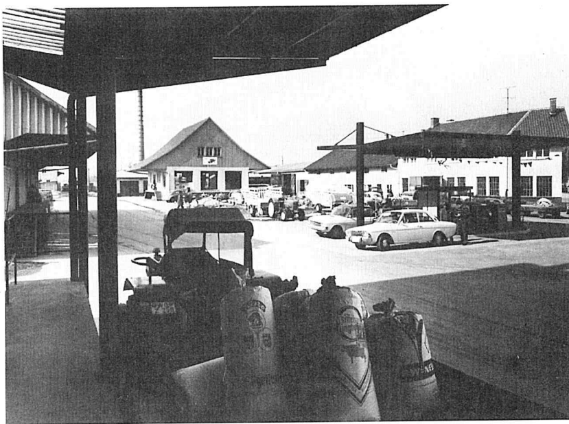
Der Betriebshof in Bad Wurzach 1968, nach dem Bau der Tankstelle
