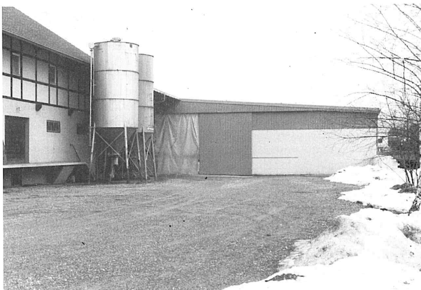
Das Lose-Düngerlager Isny ist gebaut. Der jährliche Düngemittel-Umschlag bei der BAG erreicht jetzt die Höchstmenge von 27 000 t
