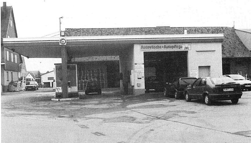
Auto-Waschanlage und Tankstelle Bad Wurzach
