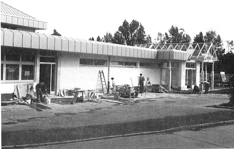
Raiffeisenmarkt Bad Wurzach - kurz vor der Fertigstellung
