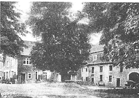
Scheuer und Autohalle des Gasthauses „zur Krone“ in Wurzach
