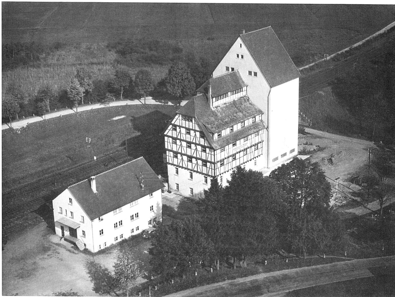
Silo, Lagerhaus und Mosterei mit Düngemittellager in Essendorf
