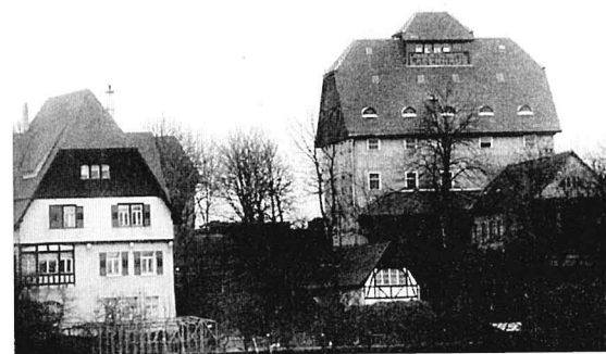
Das Lagerhaus nach der Fertigstellung
